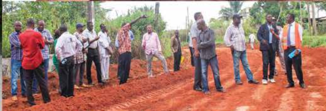
Route Revetue Stabilisée au CON-AID
